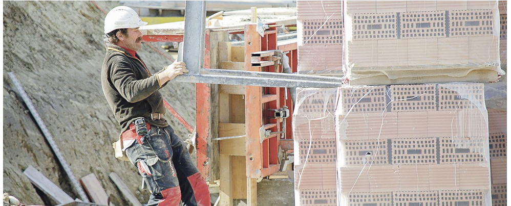
Der FAR ermöglicht Bauarbeitern ein Arbeitsende in Würde – ein Meilenstein in der Geschichte von Syna. Bild: Ernst Zülle
